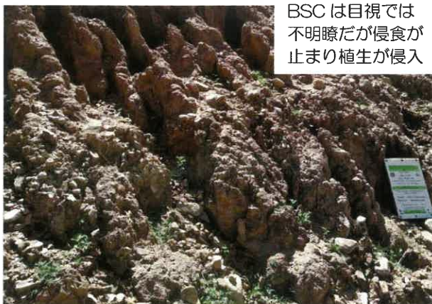
元々侵食が進行していた箇所に施工した後の状況例（豪雨後：施工2ヶ月後）
