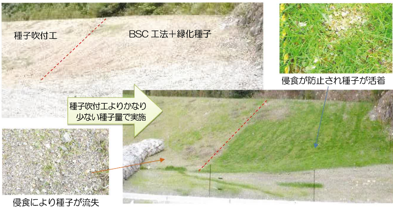
従来の種子吹付工と BSC 工法（種子入り）を比較した例
