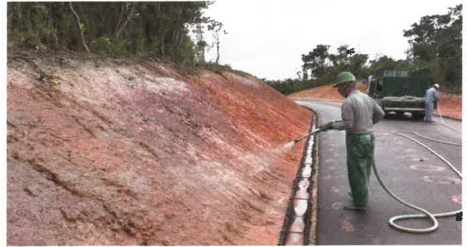
造成法面 (切土面) の例
