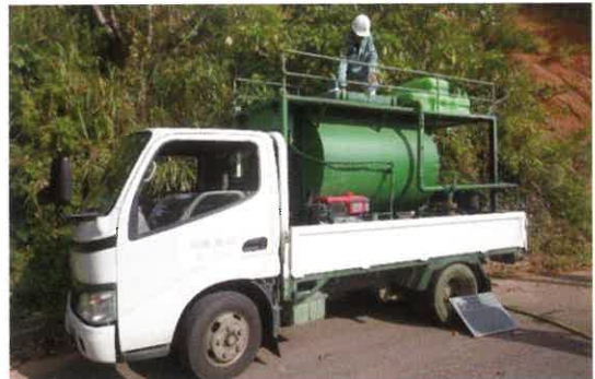
吹付機器等の例
